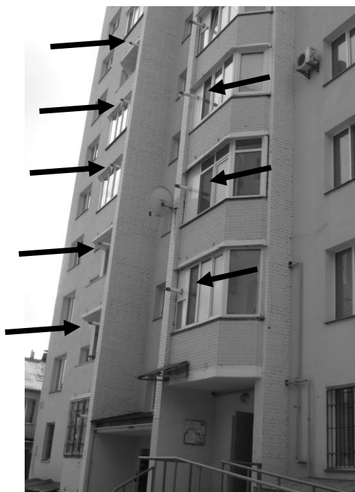
Рис 1. Джерела викидів продуктів згоряння систем індивідуального опалення
