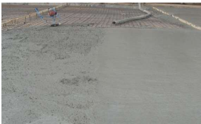
Рисунок 1. Влаштування цементобетонної основи
